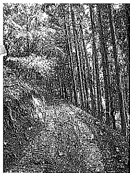
開設された作業路
